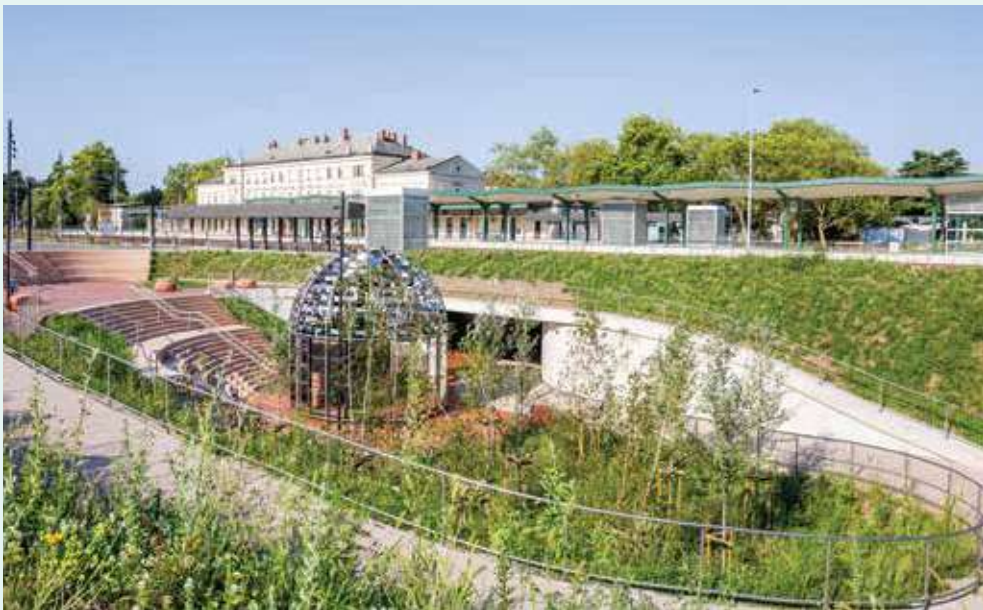
Prenovo novogoriške železniške postaje
